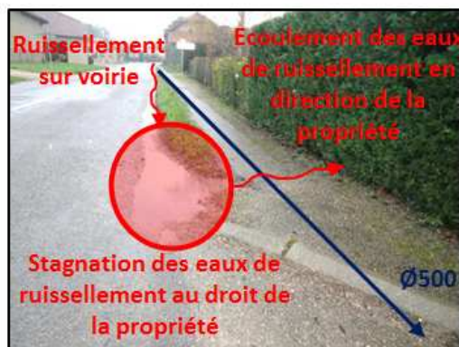
Absence d'ouvrage de collecte des eaux de ruissellement - Inondation de la propriété – Lotissement Pré de la Croix
